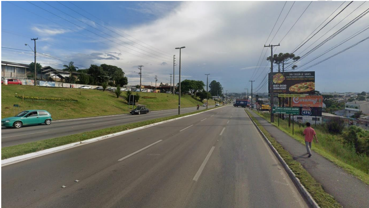
Figura 89 — Ilustração da sugestão de faixa exclusiva para ônibus na Estrada da Ribeira (antes x depois)
