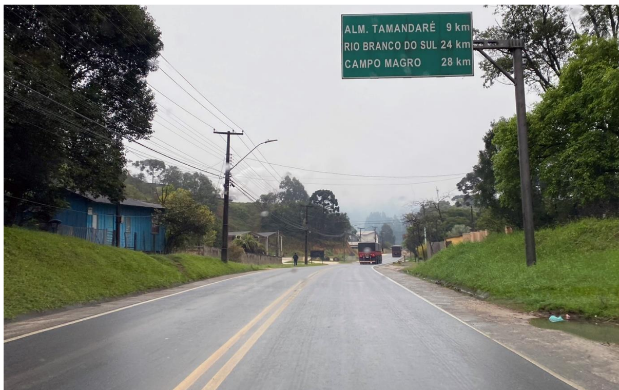
Figura 25 — PR 509 (Via estruturante)
