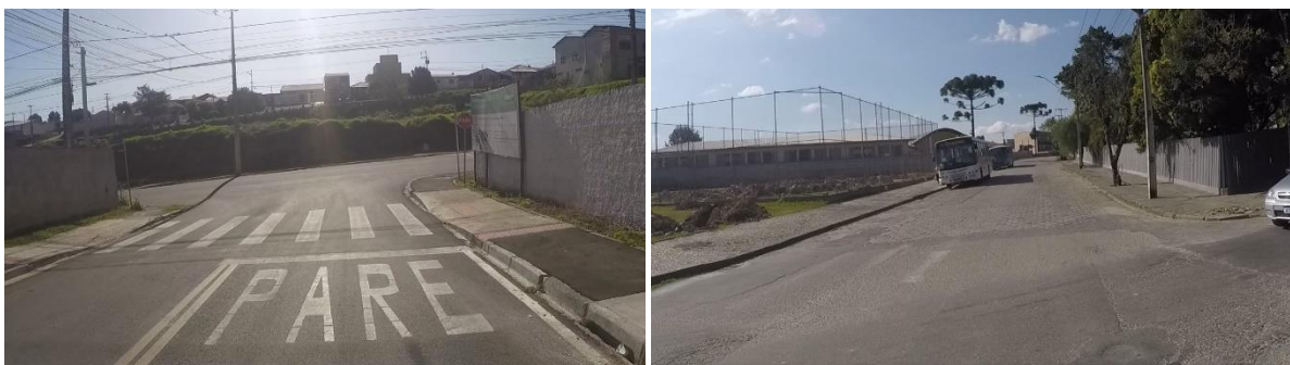
Figura 40 — Faixas de Pedestre em condição ótima e ruim (Rua Suécia e Rod. Almirante Tamandaré)
