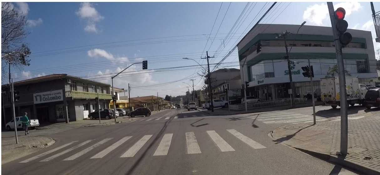
Figura 43 – Sinalização Vertical e Horizontal e Controle de Tráfego em ótima condição (Cruzamento Rua Padre Francisco Bonato e Rua José Leal Fontoura)
