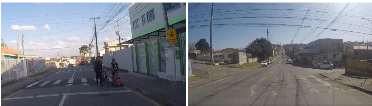
Figura 39 – Travessia Elevada em condição ótima e regular (Rua Campo Largo e Rua Santa Maria)
