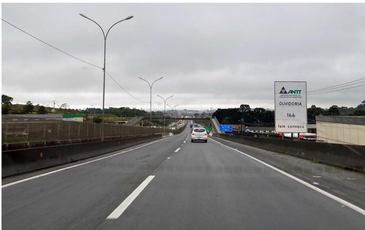
Figura 21 — BR 116 em trecho de via expressa
