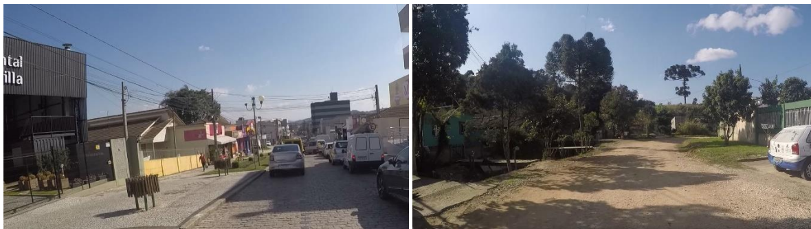
Figura 41 – Calçamento em condição ótima e ruim/inexistente (Rua XV de Novembro e Rua Nelson Argenta)
