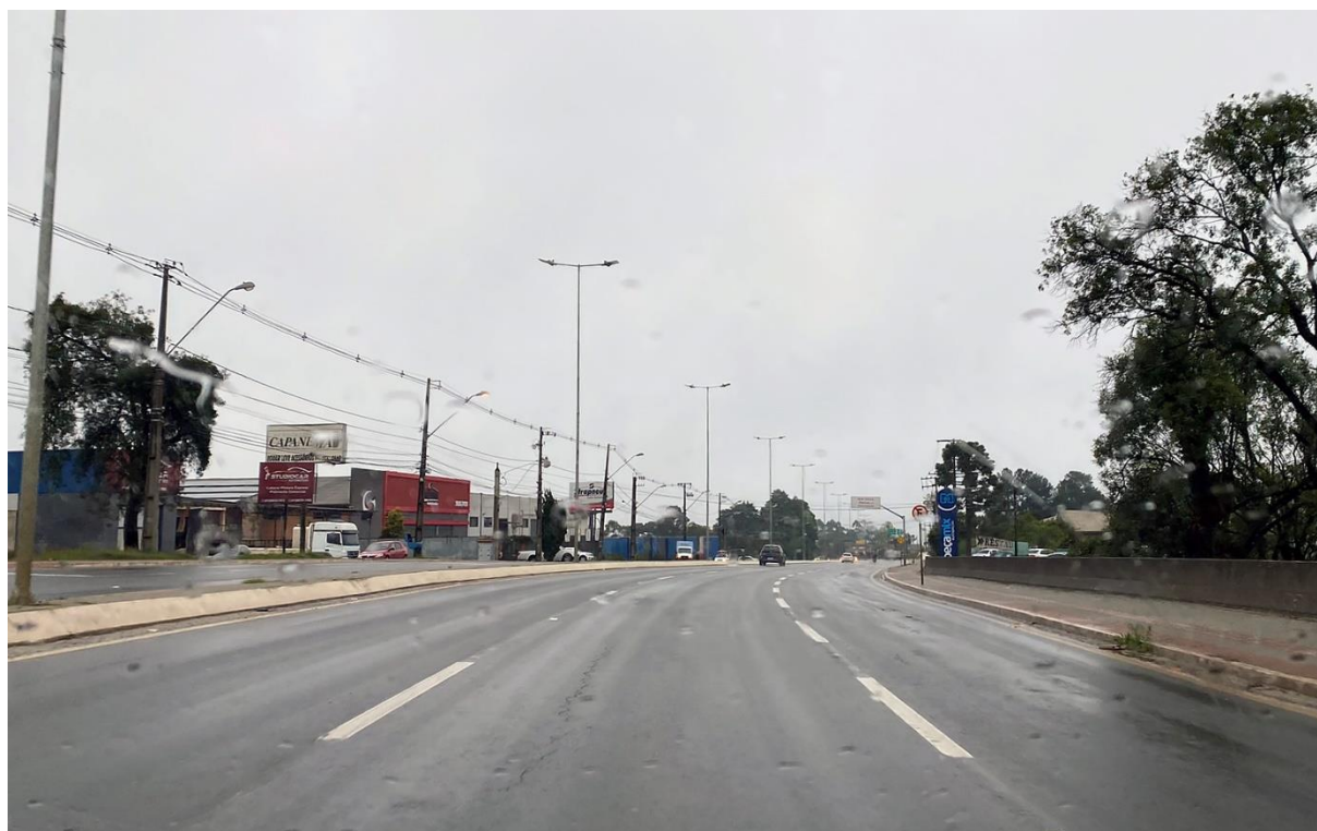
Figura 23 — PR 417 (Via estruturante)
