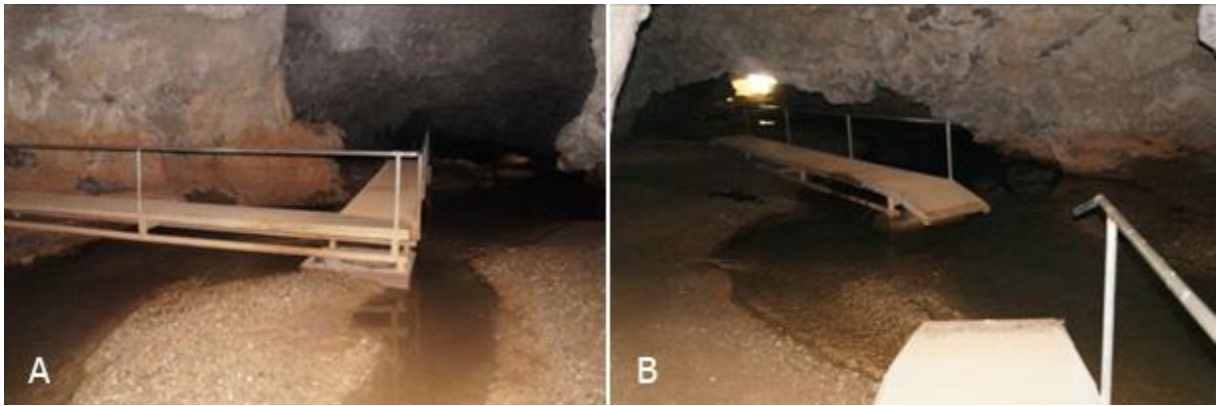
Figura 8/III - A) exemplo da influência que as passarelas provocaram na dinâmica sedimentar do rio; B) o resultado da alteração dessa dinâmica, uma passarela está completamente inutilizada pela alteração do curso d'água
